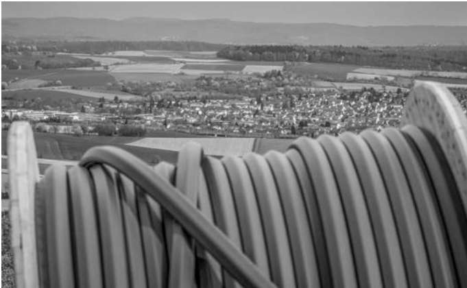
Der flächendeckende Breitband-Ausbau ist eines der großen Infrastrukturprojekte des Rhein-Neckar-Kreises. (Foto: Landratsamt Rhein-Neckar-Kreis)
